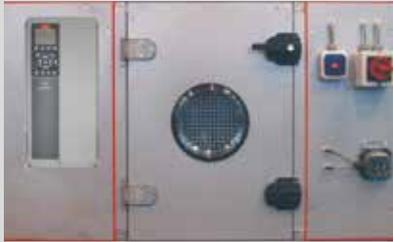
Pour la régulation progressive de la vitesse [5 à 90 Hz] du moteur de ventilateur avec caractéristique de couple quadratique, antiparasitage selon EN 55011 et EN 61800-3 via filtre antiparasitage. Câble de raccord blindé entre moteur et transformateur de fréquence. Protection moteur intégrée via surveillance par thermistance CTP. En combinaison avec une armoire de commande, câblage et pré-paramétrage en usine.
