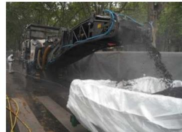
Afin de limiter les émissions et dispersions de fibres d'amiante lors de procédés de réfection de chaussée avec enlèvement d'enrobés amiantés et pose d'enrobés neufs, la Direction de la voirie et des déplacements (DVD) a sollicité le LAFP pour suivre un nouveau procédé de thermo-réparation à froid sur une zone test.
